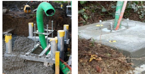
Bilder: betonieren und erstellen des Fundamentes
