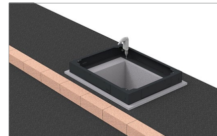
Abbildung: Bohren der Positionsbohrungen für Betonanker M10 mit Sockel als Lehre
