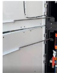
Um die Isoliersicherheit zu gewährleisten, sind vor der Batterie vier Schutzplatten angebracht. Die Schutzplatten müssen zuerst demontiert werden, bevor die Kupfersammelschiene mit der Batterie verbunden werden kann.
